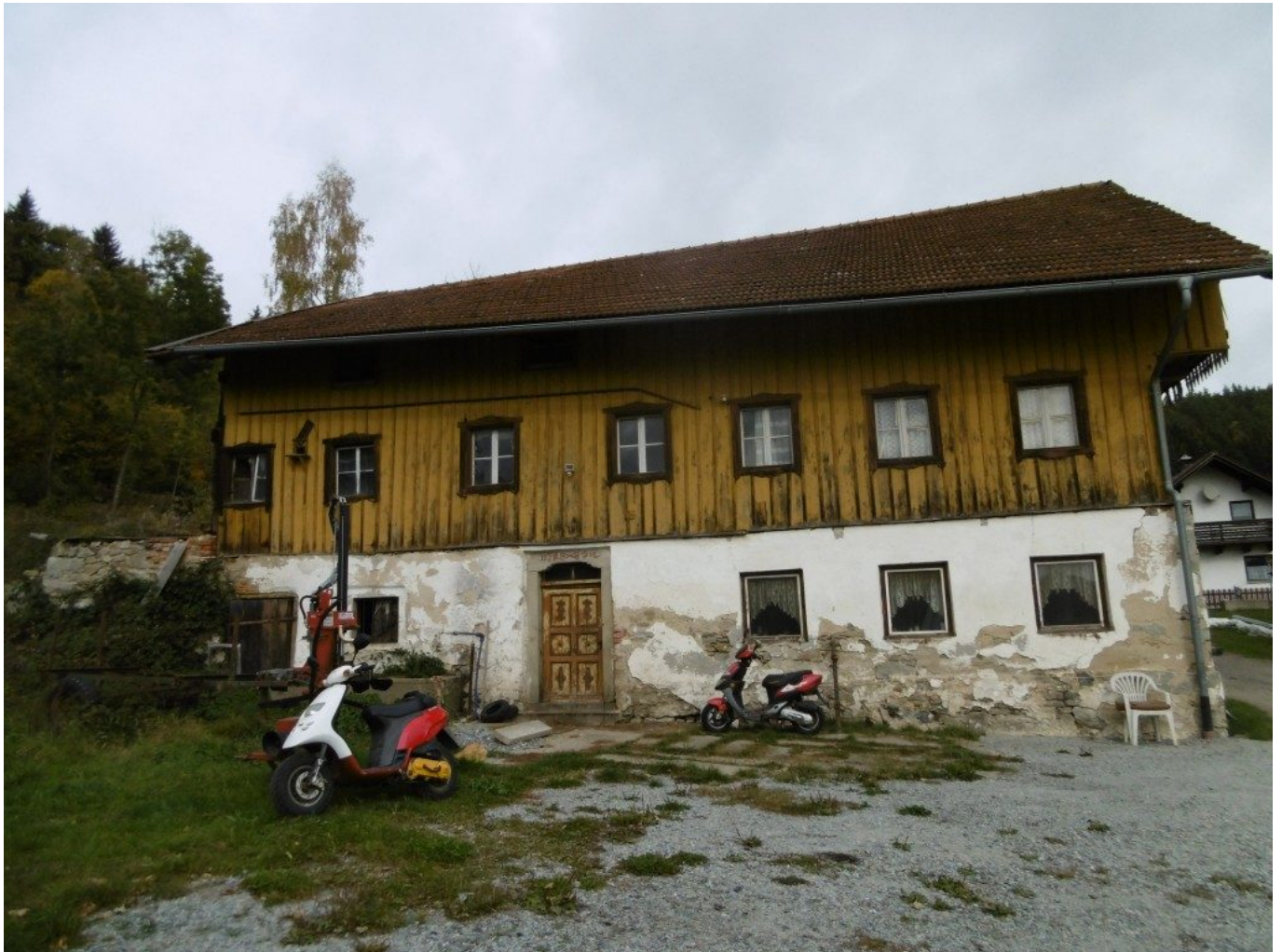
Das Penzkofer-Anwesen liegt am Wolfgangsweg nach Ramersdorf
